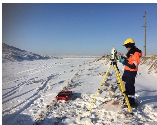
13 Сурет – T1 станциясында тахеометрмен жұмыс
